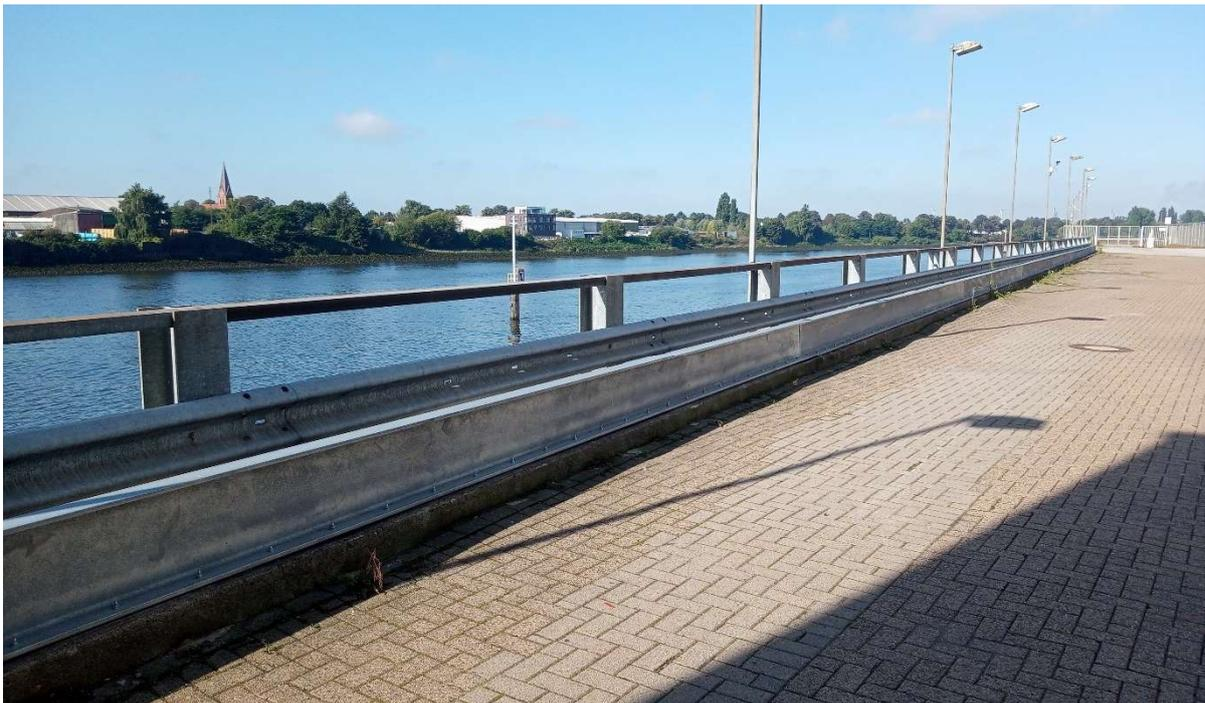
Abbildung 9: Hochwasserschutzanlage als UPE 400-Profile, Foto IL vom 28.09.21
